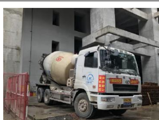
混凝土搅拌车
