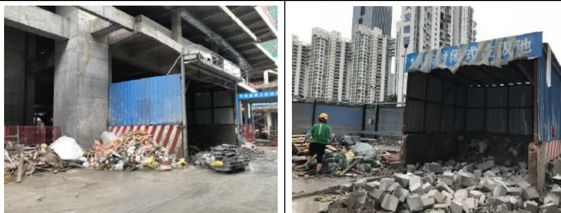
建筑垃圾定点定期清运
